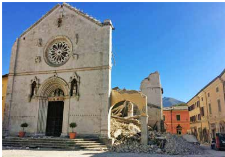
La chiesa di Norcia distrutta dal terremoto
